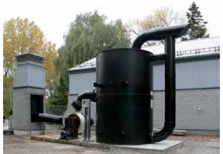
TCA double étage extérieure en STEP
