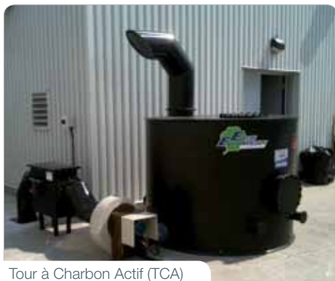
Tour à Charbon Actif (TCA)
