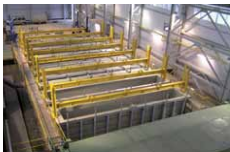
GALVANISATION À CHAUD
