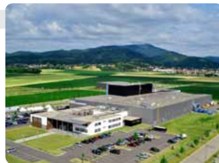
L Bâtiment J
