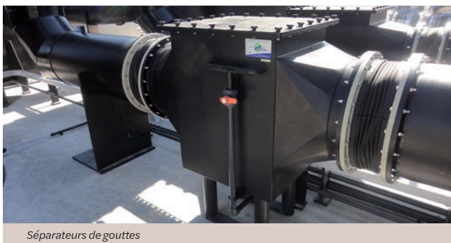
Séparateurs de gouttes
